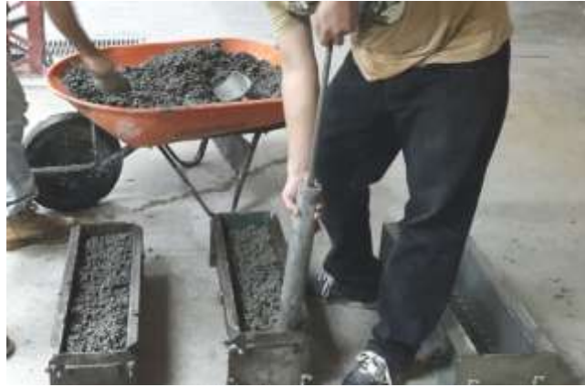
FIGURA 3. 6 Colocación y Compactación de concreto permeable fresco
