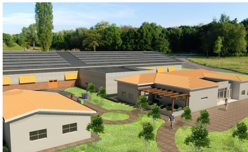
Vista Exterior de Apoyo y preparación de Alimentos y Bodega.
