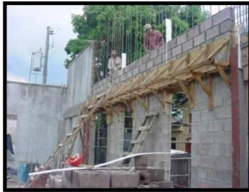
Imagen 68: Construcción de paredes perimetrales
