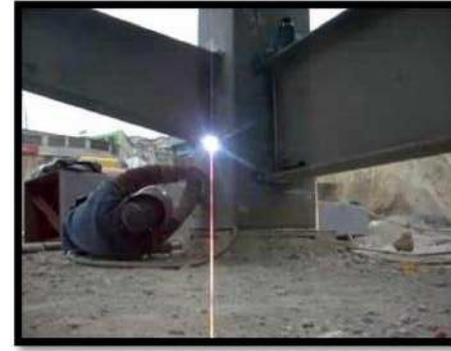
Imagen 67: soldadura de conexiones in situ
