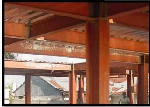
Imagen 66: conexiones entre vigas y columnas
