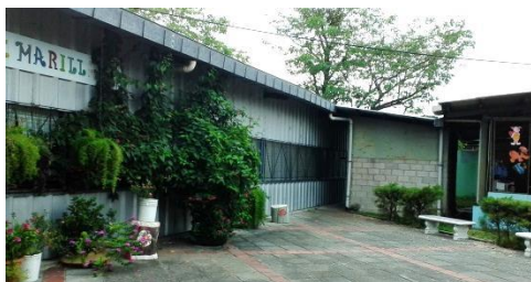
6. Edificio de lámina con función de aulas
