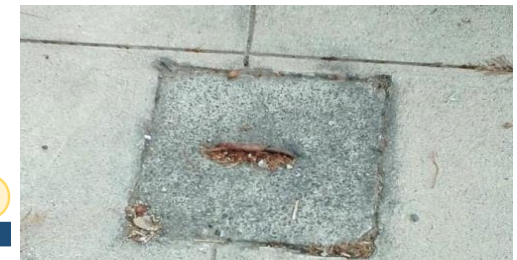
Imagen-III-12- Acometidas de agua potable en el Edificio "Verde"
