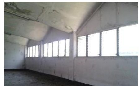
Imagen-III-48- Ventana de celosía de vidrio
