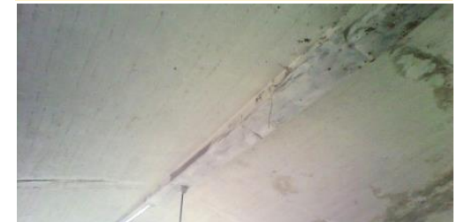
Imagen-III-10- Detalle de Canal
