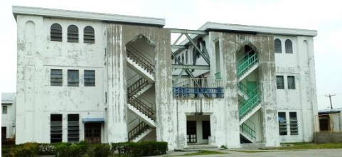
3. Edificios comedor y de oficinas, con perfilaría exterior de refuerzo estructural
