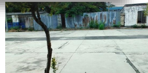
8. Edificios abandonados frente al edificio verde
