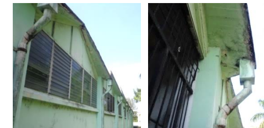
Imagen-III-11- Detalle de bajadas de aguas lluvia
