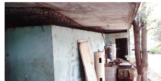
1. Bodega, con techo de losa tipo cascarón.
