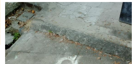
Imagen-III-15- Acometida de Agua Potable hacia Talleres en edificio"
