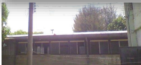
7. Edificio de bloque y techo de lámina con función de aulas
