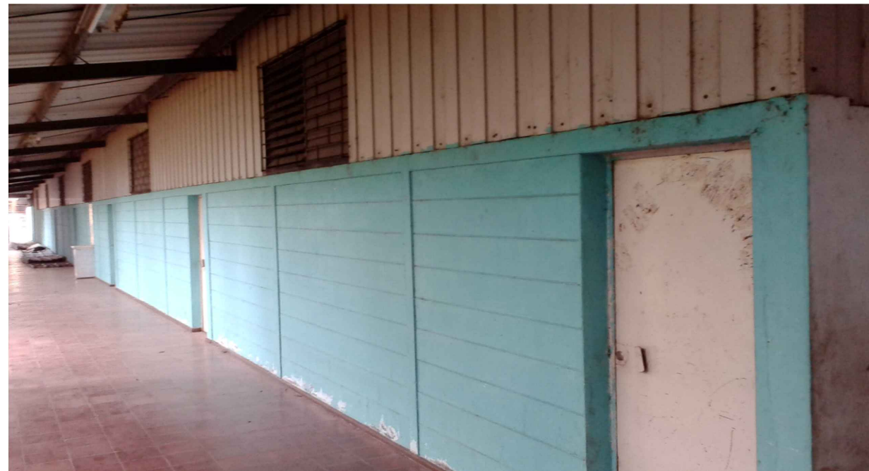
En el entorno del Edificio Verde y parte del área intervenida, se ubican edificaciones que se son utilizadas como bodegas, las cuales estan construidas con materiales prefabricados livianos.
