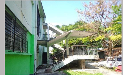
3. Acceso principal al edificio "Verde"
