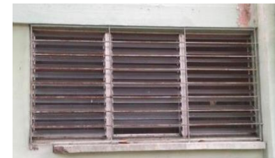
Imagen-III-44- Ventana de celosía de vidrio
