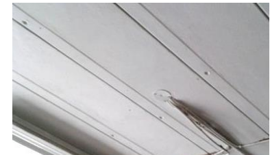
Imagen-III-43- Acabado de losa densa vista
