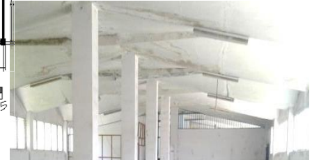
Imagen-III-46-Acabado en techo de losa densa vista
