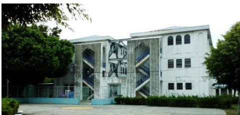
5. Edificios de habitación, con perfilaría exterior de refuerzo estructural
