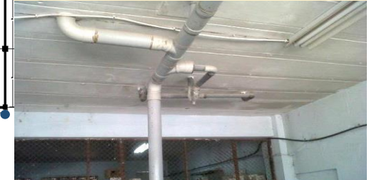
Imagen-III-13- Bajada de Aguas Negras en el Edificio Verde
