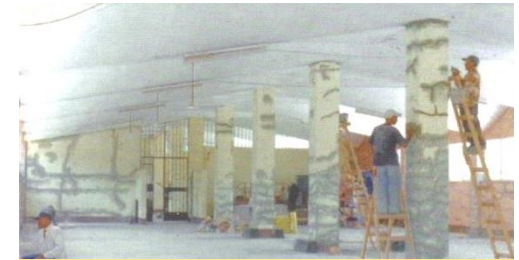
Imagen N° III-5- Reparación en columnas
