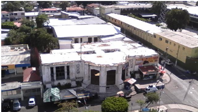
Imagen 69: Antigo Palacio Municipal Fuente: Archivo Propio
