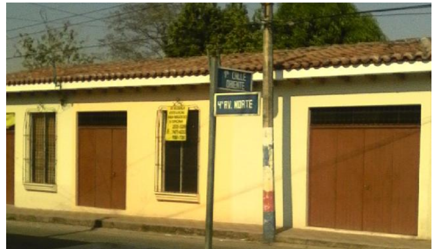
Imagen 35: Vivienda ubicada sobre la 4 Av. Norte y 1 Cl. Oriente. Fuente: Archivo Propio
