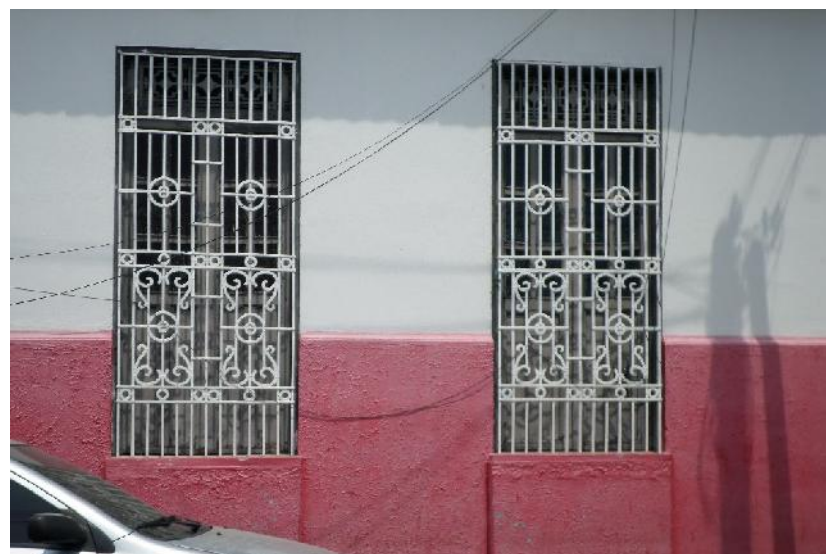
Imagen 65: Remates en Fachada Fuente: Archivo Propio
