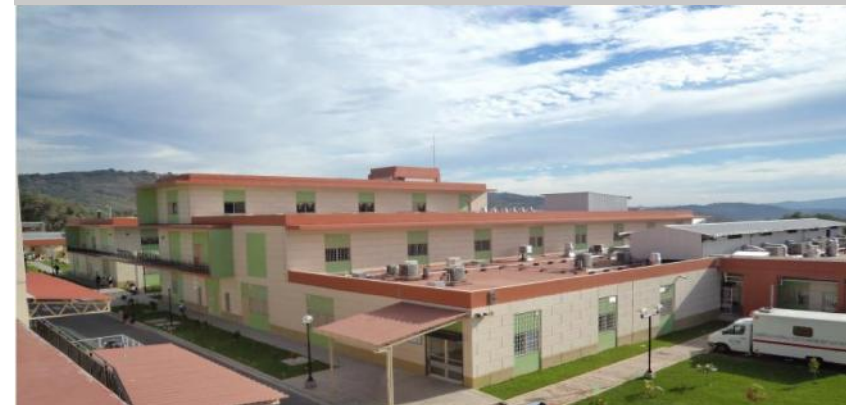
Imagen 54: Hospital Nacional Santa Gertrudis Fuente: Archivo Propio
