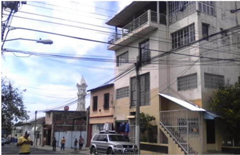
Imagen 68: Edificación de 4 Niveles Manzana D-4 Fuente: Archivo Propio
