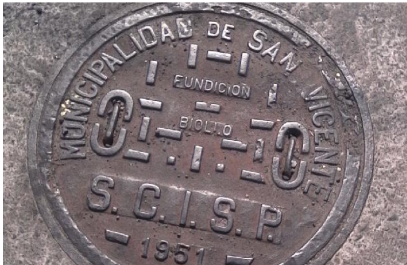
Imagen 98: Pozo de Aguas Negras Fuente: Archivo Propio
