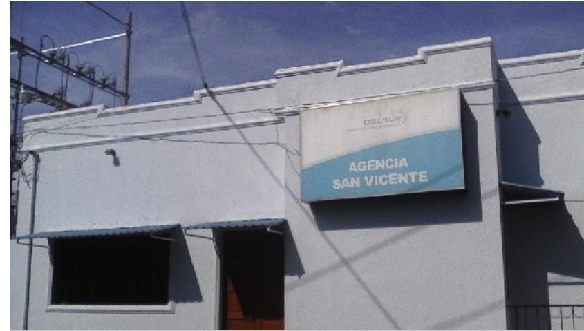
Imagen 59: Central Eléctrica Del Sur Fuente: Archivo Propio
