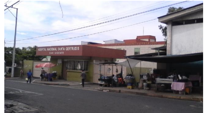
Imagen 16: Hospital Santa Gertrudis Fuente: Archivo Propio
