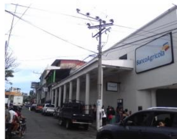
COSTADO 5, PERFIL SUR
