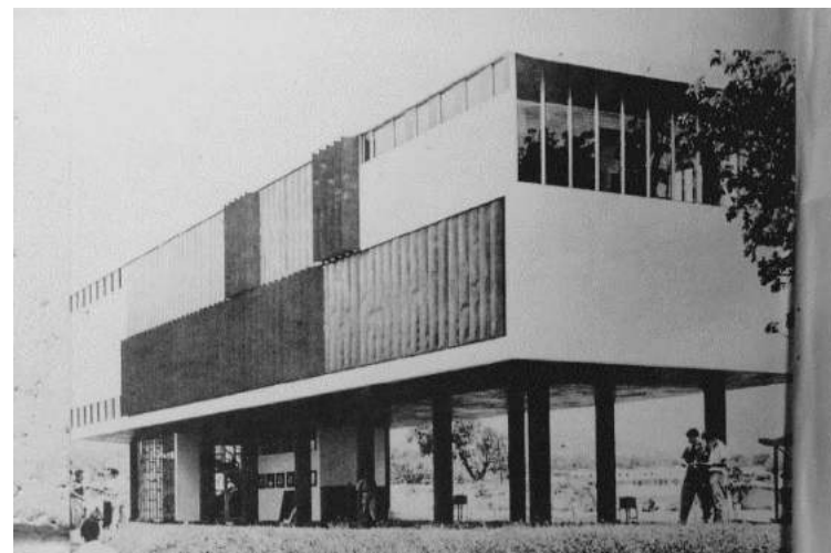
IMAGEN 10 : Facultad de Ingeniería y Arquitectura años 70s
