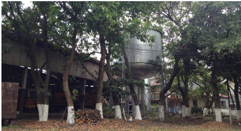
Fotografía 53. TANQUE DE AGUA POTABLE Fuente: Visita de campo.
