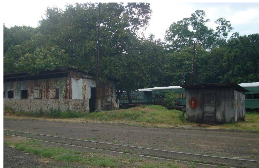
Fotografía 58. Tanque de gasolina. Fuente: Visita de campo.
