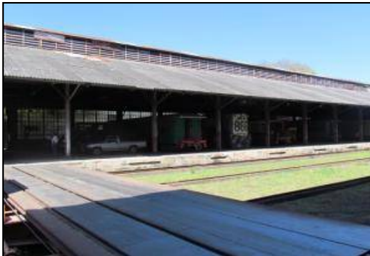
Vista de la fachada Este de la Nave 1 que contiene las áreas de carpintería, reparaciones mayores y pintura.
