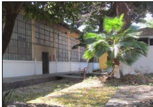
Vista de la fachada Poniente de la Nave 1, en ella se observan grandes ventanales de vidrio fijo.
