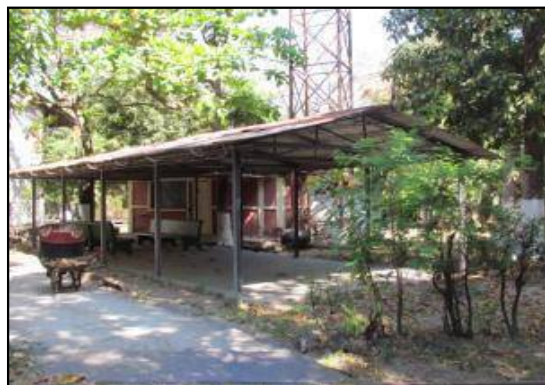
Antes área de cafetería, actualmente fuera de uso.
