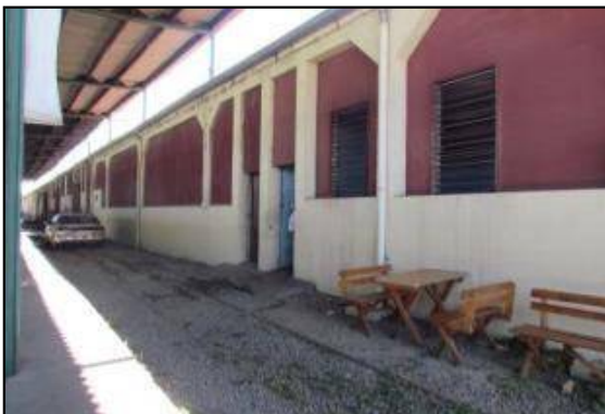
Vista de la fachada Nor-poniente de la bodega de carga local.
