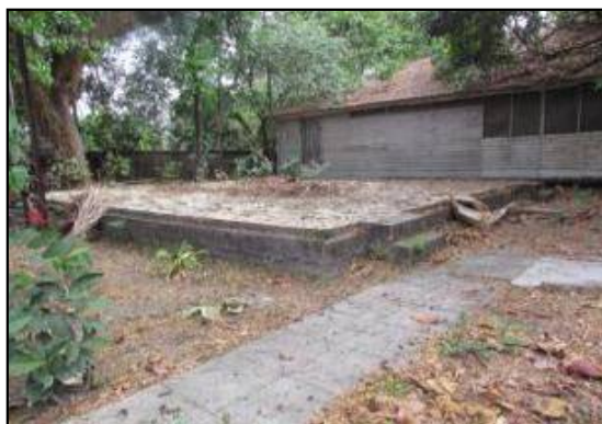
Vista de plataforma o rampa antes se encontraba el departamento de vías y estructuras . El sistema constructivo era de lámina y madera.
