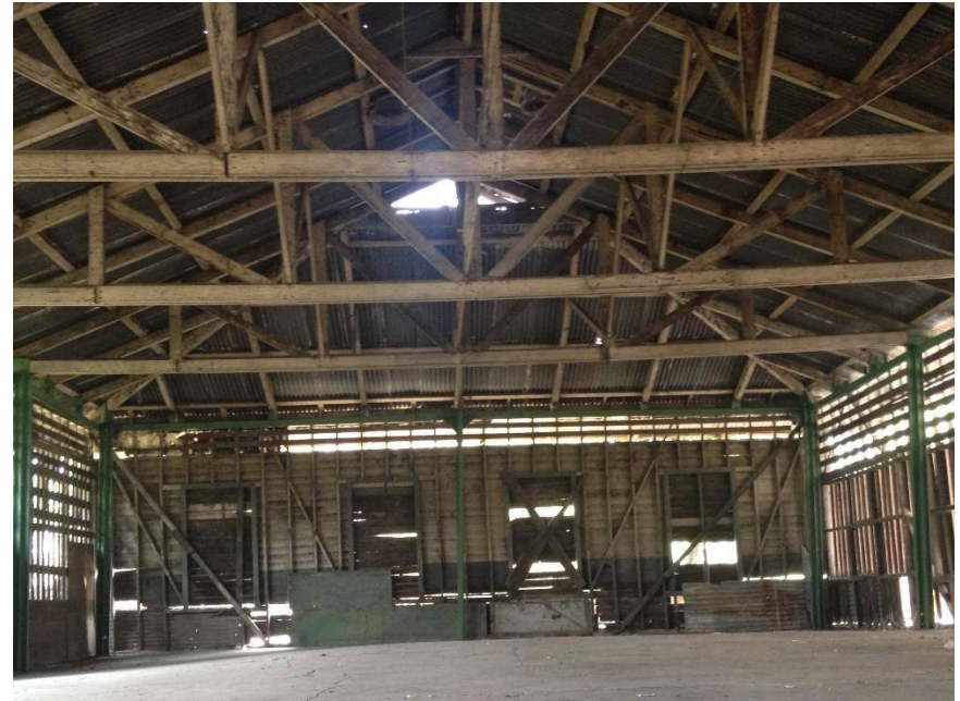
Fotografía 19. Cerchas en Ex Imprenta, Estación FENADESAL San Salvador. Fuente: Visita de campo
