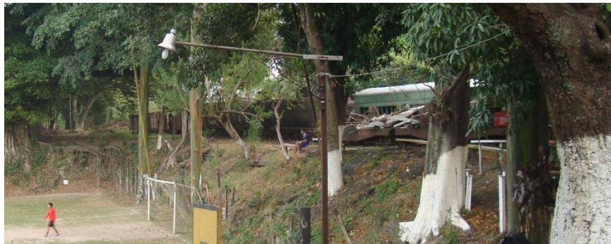
Imagen 29: Vista del talud perimetral a la cancha de futbol. Fuente: Visita de campo
