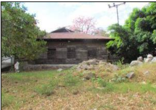
Bodega vista de la fachada Norte, sistema constructivo de madera y techo de lámina .
