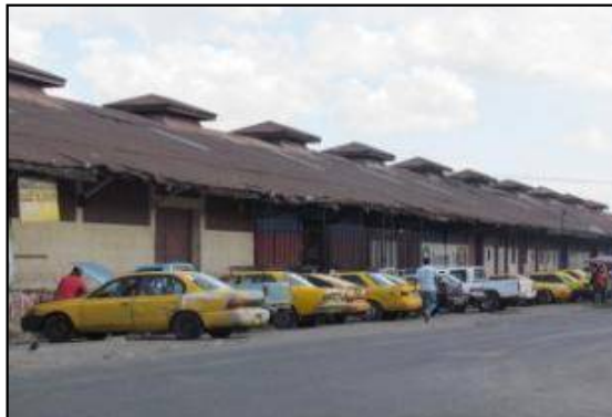
Vista de la fachada Sur-este de la bodega de carga local.
