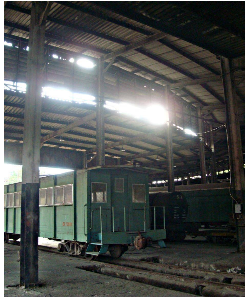
Fotografía 8. Sistema constructivo de lámina con estructura de perfiles metálica, la casa redonda, estación FENADESAL San Salvador.. Fuente: Elaboración propia.
