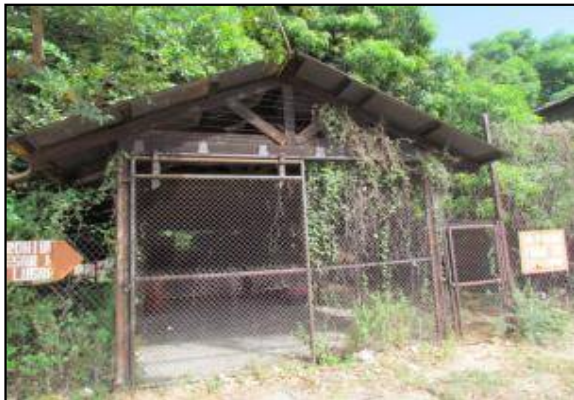
Tanque de gasolina.
