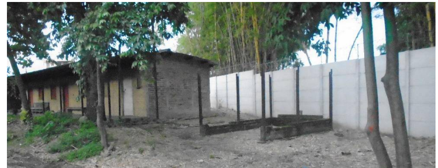
Fotografía 70: Vista actual del área de la estación y seguridad. Fuente: Visita de campo
