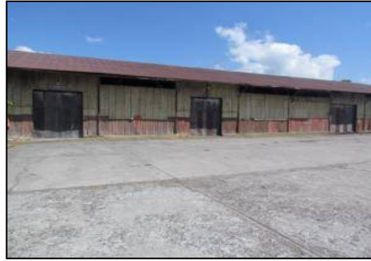
Bodega Nº 2, Vista de la fachada Sur.
