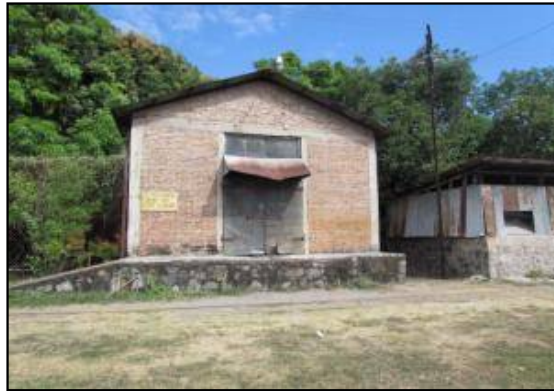
Área de lubricantes, sistema constructivo ladrillo de barro cocido esta construcción ha sido marcada para demolerse.
