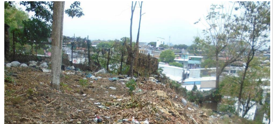
Imagen 25: Vista del borde de talud que colinda con Comunidad Iberia.
