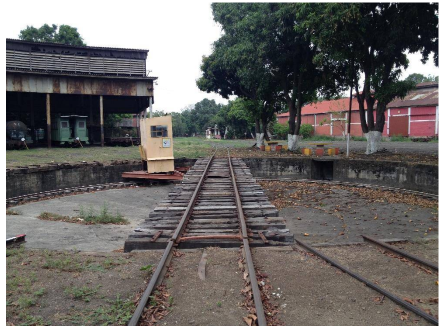
Fotografía 14. Tornamesa Estación FENADESAL San Salvador. Fuente: Visita de campo
