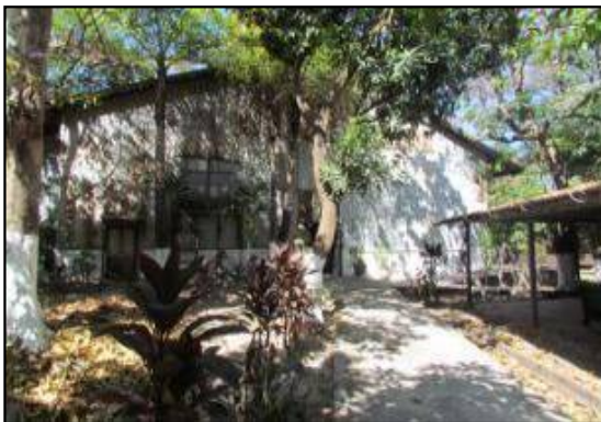
Vista de la fachada Este de la Nave 3.
