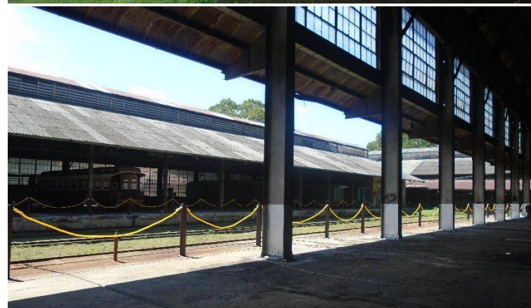
Arriba: Fotografía 39. Vista de naves 1 y 2. En medio: Fotografía 40. Vista de nave 3. Abajo: Fotografía 41. Vista interior de naves 1 y 2. Fuente: Visita de campo
