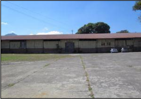
Bodega Nº 2, Vista de la fachada Norte .
