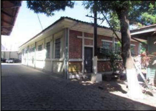
Gerencia vista de la fachada Sur-oriente.
