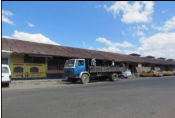
Vista de la fachada Sur-poniente de la Bodega de carga local.
