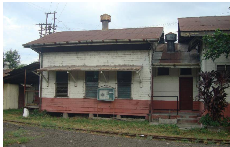
Fotografía 55. Despacho de trenes Fuente: Visita de campo.
