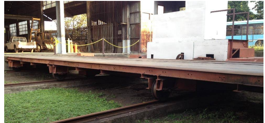
Fotografía 68. Vista de la mesa de transferencia (hmx) = 0.4'm Fuente: Elaboración propia.
