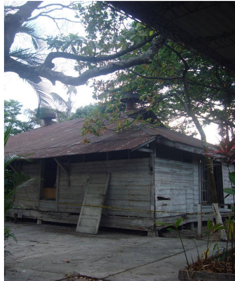
Fotografía 7: Antigua casa donde se hospedaban los funcionarios ingleses del IRCA, estación FENADESAL San Salvador. En la imagen se puede apreciar el sistema constructivo a base de madera y techo de lámina. Fuente: Elaboración propia.
