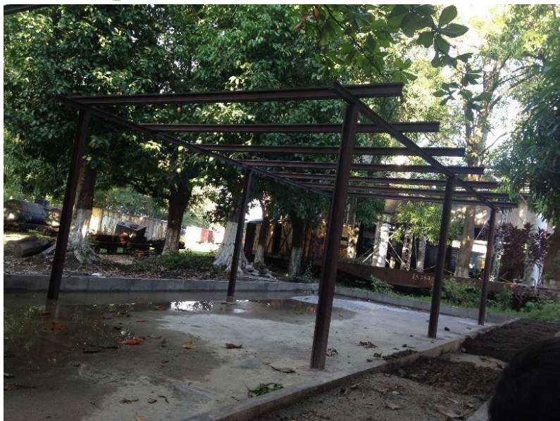
Fotografía 51. AREA TECHADA. Fuente: Visita de campo.
