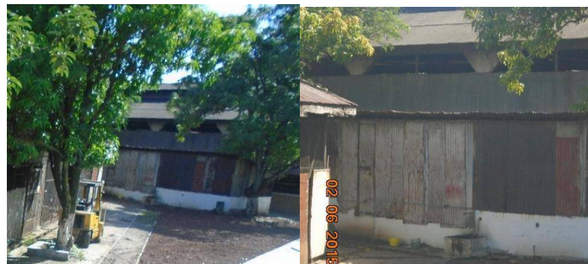
Fotografías 59 y 60. TALLER DE REPARACIONES Fuente: Visita de campo
