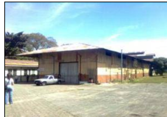
Vistas de la bodega Nº 3 sistema constructivo lámina acanalada en pared y techo, estructura de soporte de madera. Techo a cuatro aguas.
