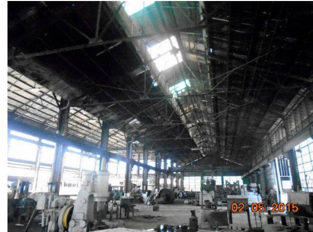
Fotografía 10. Vista interior Inmueble con valor patrimonial arquitectónico. Fuente: Visita de campo
