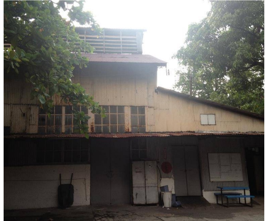
Fotografía 63. Mantenimiento. Fuente: Visita de campo.
