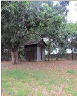
Caseta de bomba de agua fuera de uso.
