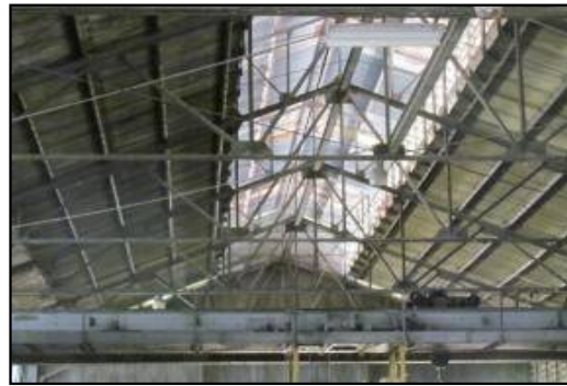
Vista de la estructura de techo de la Nave Nº 2.
