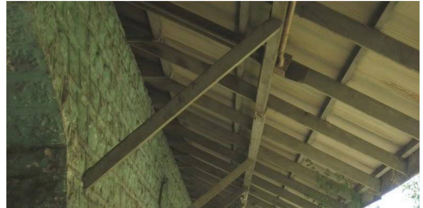
Fotografía 17. Escopeta anclada a pared de adobe, actuando de apoyo para estructura de techo. Fuente: Skyscrapercity
