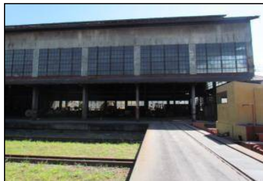
Vista de la fachada Poniente de la Nave 2, en ella se observan grandes ventanales de vidrio fijo.
