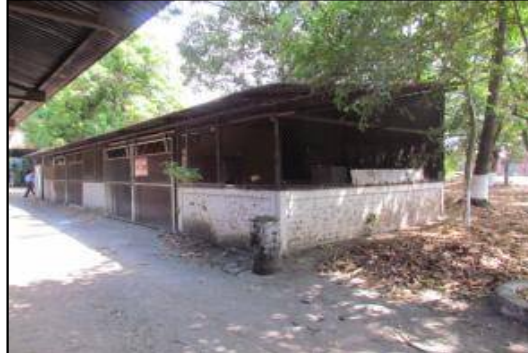
Taller de soldadura.
