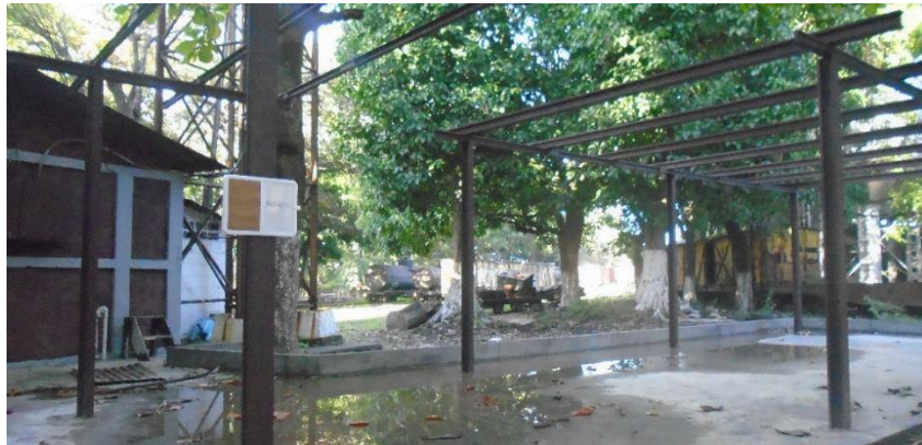
Fotografía 69: Vista actual del área de pérgola. Fuente: Visita de campo
