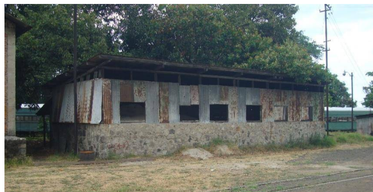
Fotografía 56. Bodega de arena Fuente: Visita de campo.
