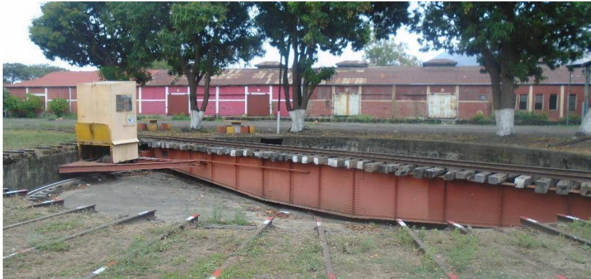
Fotografía 71: Vista actual del tornamesa Fuente: Elaboración propia
