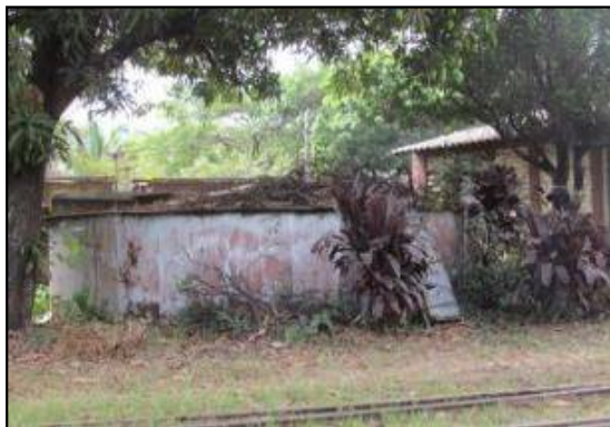
Tanque para gasolina, fuera de uso.
