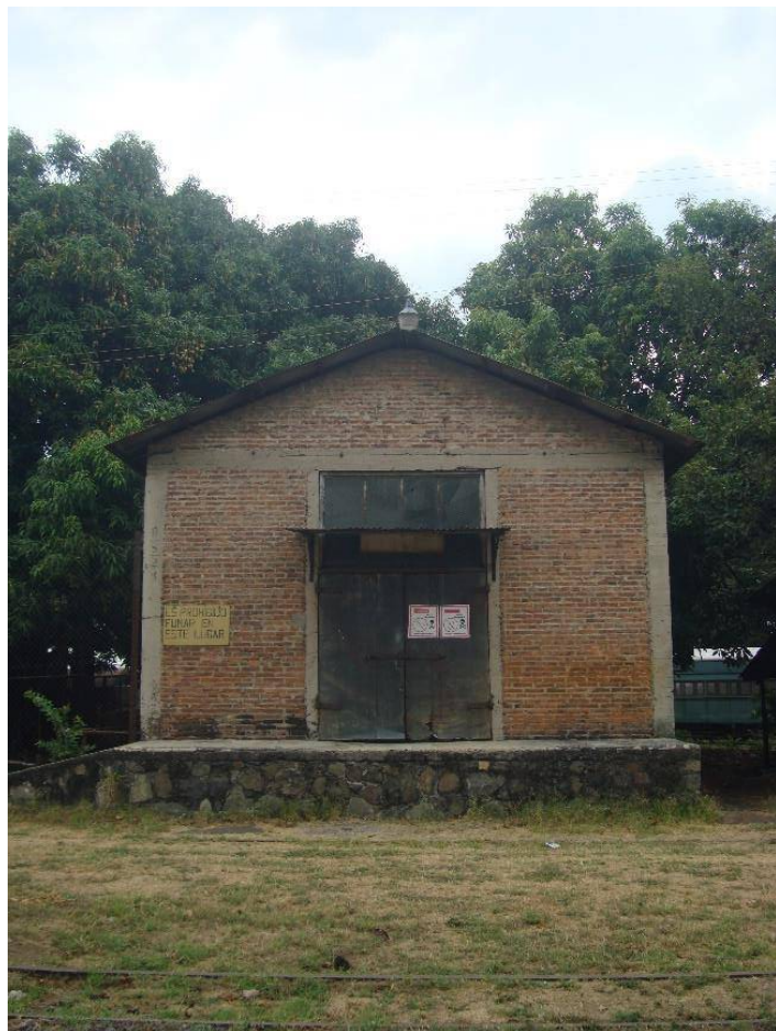
Fotografía 57. Área de lubricantes. Fuente: Elaboración propia.
