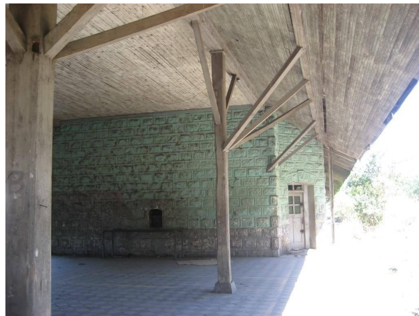
Fotografía 16. Detalle típico de columnas encontradas en las estaciones ferroviarias. Fuente: Skyscrapercity
