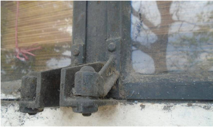
Fotografía 18. Hierro forjado en marco de ventanas, FENADESAL San Salvador. Fuente: visita de campo
