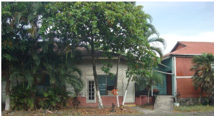
Fotografía 54. Oficina de celador. Fuente: Visita de campo.
