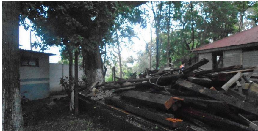
Fotografía 47. Ex-dificio de vías y estructuras, Fuente: Visita de campo
