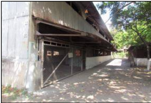
Taller de fundición actualmente de carpintería fina O Cuadrilla E-5.
