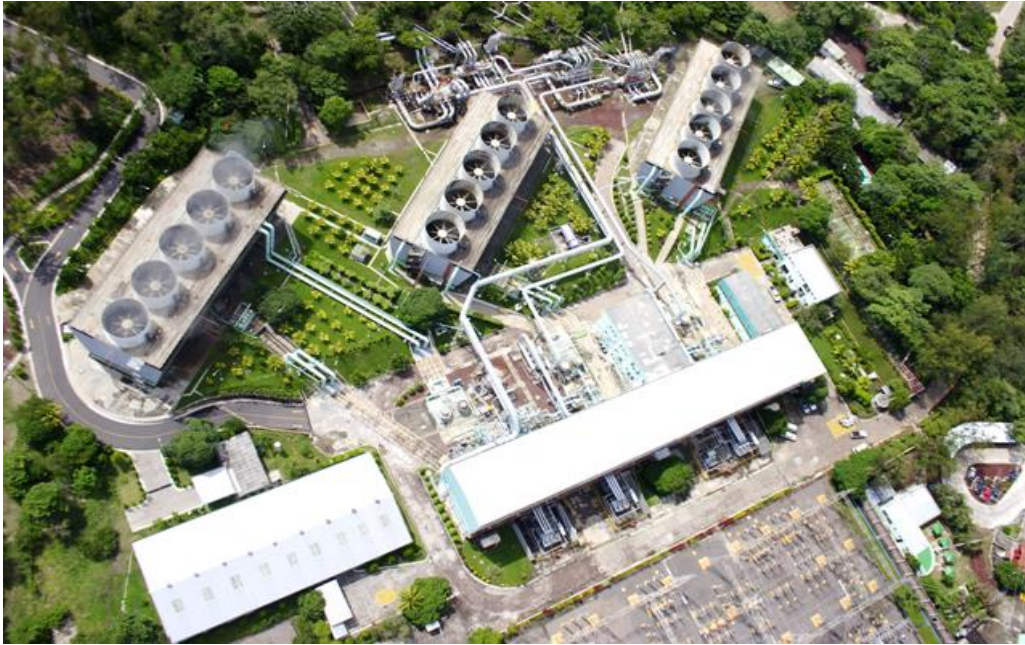
Figura 4-9 Vista de la planta geotérmica de Ahuachapán.
