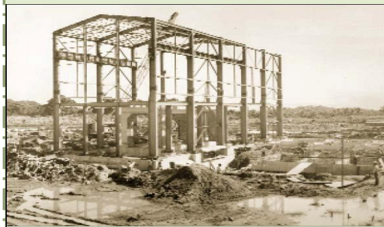
Imagen 6: Inauguración de la Planta Geotérmica de Ahuachapán 60 MW
