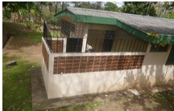
Imagen 28: Fachada posterior de vivienda en el campamento de Ahuachapán
