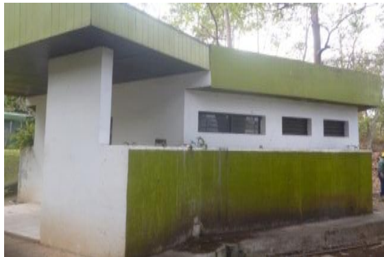
Imagen 32: Sistema constructivo en el campamento de Ahuachapán.
