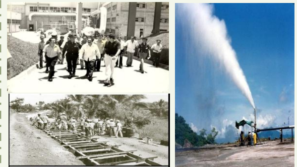
Imagen 7: Inauguración de la Planta Geotérmica de Ahuachapán 60 MW
