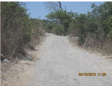
Imagen 52: Servidumbre al terreno
