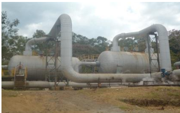
Imagen 9: separador ciclónico
