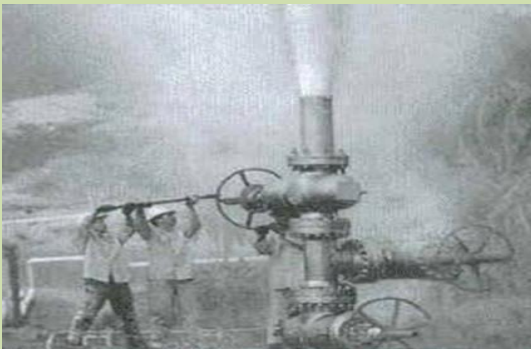
Imagen 5: Perforación de pozos Ah-1
