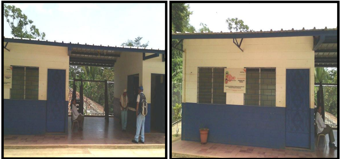
Fig. 10 Infraestructura de la escuela, Caserío San Rafael
