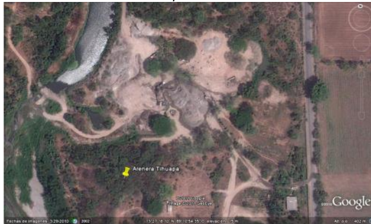
FIGURA No 4.9: Planta de extracción y lavado de arena natural en el río Tihuapa.
