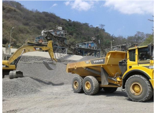
FIGURA No 4.7: Acopio del material.
