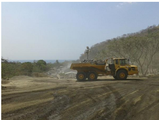
FIGURA No 4.4: Transporte de materiales.
