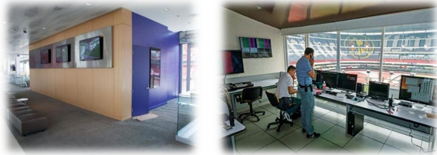
Ilustración 106 Sala de control de seguridad
